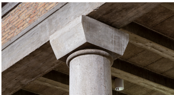
Architectonische details: zuil met ring en blokkapiteel waarop de architraaf rust. De afdrucken van de bekistingsplanken zijn nog zichtbaar in het beton.
