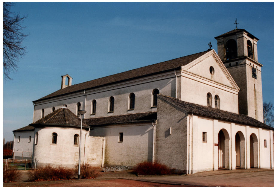
De H. Hart van Jezuskerk in De Horst (Groesbeek) is een ontwerp van Nico van der Laan uit 1952. De kerk is een mooi voorbeeld van een Bossche Schoolbasilica, waarbij plattegrond en vormentaal zijn geïnspireerd door vroegchristelijke architectuur.
